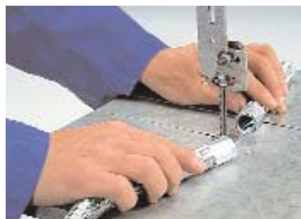
Saubere Trennung ohne Fasern durch die Umwicklung mit Metall-Klebeband Conduit ends are clean without splaying, due to adhesive tape binding
