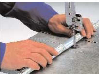
Trennstelle ca. 2-3x mit Metall-Klebeband umwickeln Bind conduit with metal adhesive tape at the cutting position 2 or 3 times
